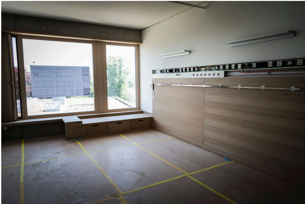
Blick in ein künftiges Patientenzimmer im neuen Kinderspital.
